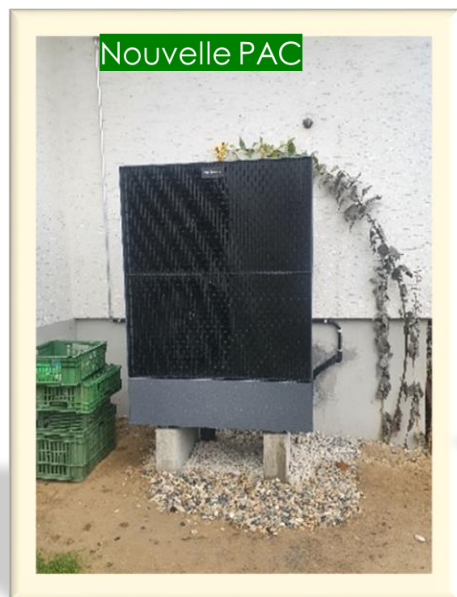
Isolation et changement du chauffage
