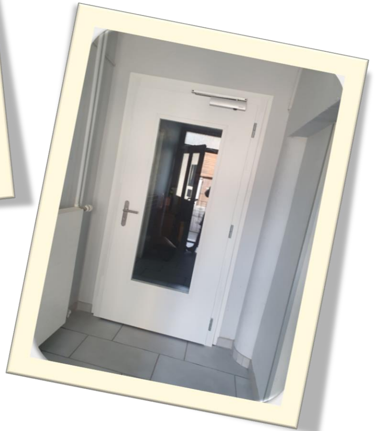
Remplacement de la porte battante anti-feu du hall du restaurant
